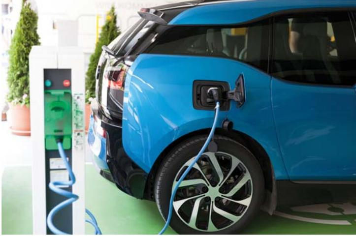
的標準，以及應在充電設備插座的上方配備一個斷流裝置，以在插入充電連接器後開電源和在拔出充電連接器前關掉電源。於戶外使用和安裝在公共場所及停車場的充電裝置則應符合合適的防護等級要求。至於故障防護方面，除採用電氣性分隔保護措施的電路外，每個充電點至少應受內部A型電流式漏電斷路器保護，而該電流式漏電斷路器須符合守則11J所訂明的特性。除非是由電動車輛充電設備提供保護措施，每個帶有充電插座或連接器(符合IEC 62196系列)的充電點，均應採取針對直流故障電流的保護措施，包括使用B型電流式漏電斷路器或能於直流故障電流超過6mA時可將電源截斷的A型電流式漏電斷路器及合適設備。其他相關技術指引及要求的詳情載於守則26S。
