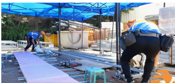
圖5 工地外加工場
