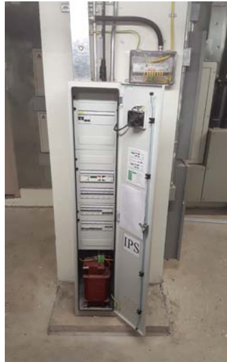
隔離電源系統
