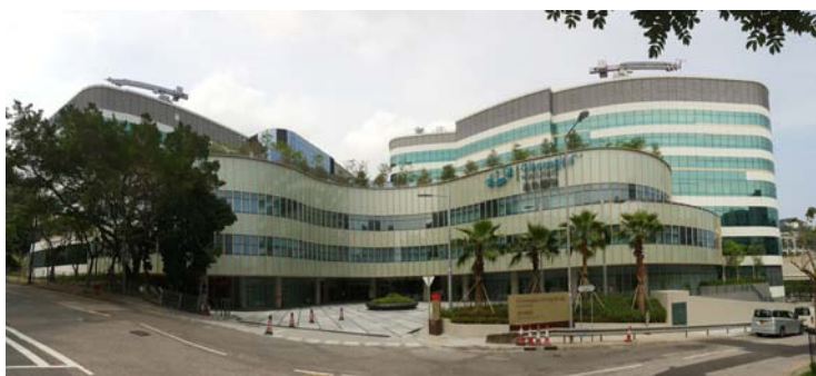
港怡醫院外貌
